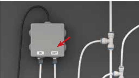
Verbinden Sie das Rückschlagventil mit dem Magnetschalterventil OUT.
